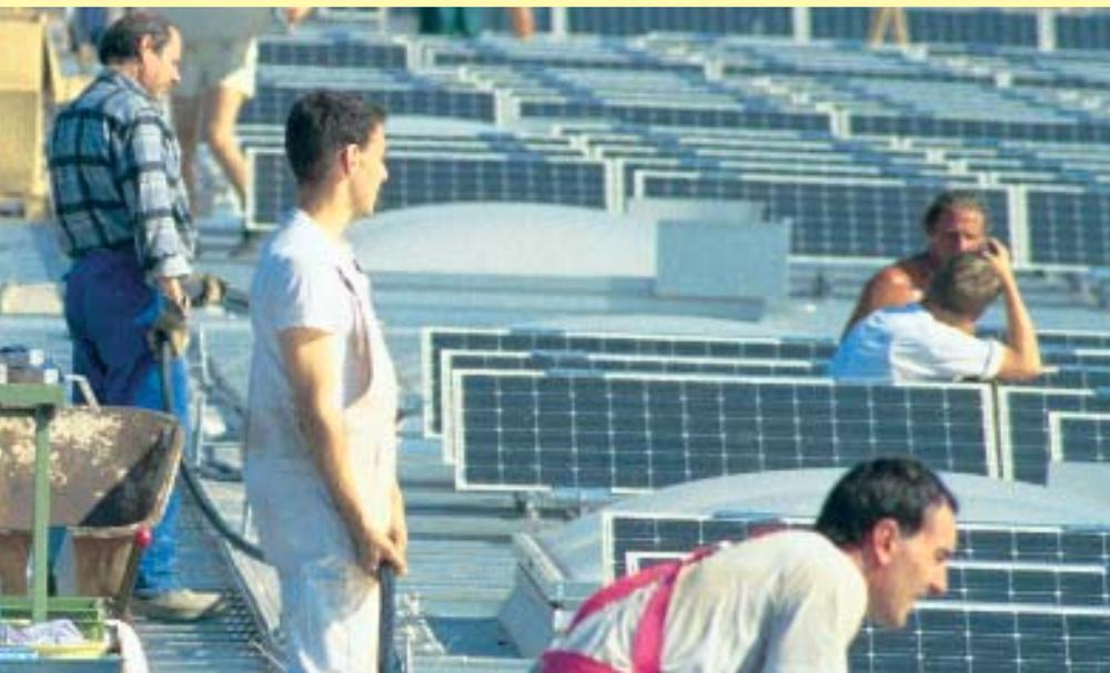
Nur 40 Arbeitstage standen zur Verfügung, um auf sechs Hallendächern Photovoltaikanlagen mit jeweils 176,4 Kilowatt Spitzenleistung zu installieren.
