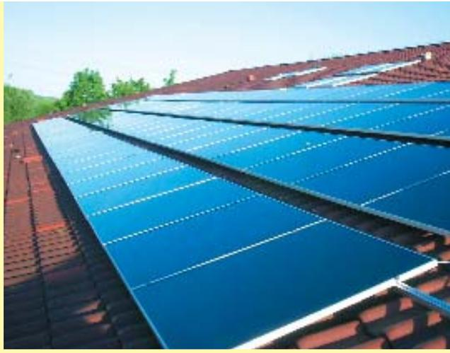
*Module aus amorphem Silizium (a-si) bringen auch bei schwacher Sonneneinstrahlung gute Stromerträge. Die Phönix SonnenStrom AG ist bisher der einzige Anbieter des a-si-Moduls des Herstellers Mitsubishi Heavy Industries außerhalb Japans. Die erste SonnenStrom Anlage, die mit diesen Solarmodulen in Deutschland gebaut wurde, hat 11 Kilowatt Spitzenleistung.*
