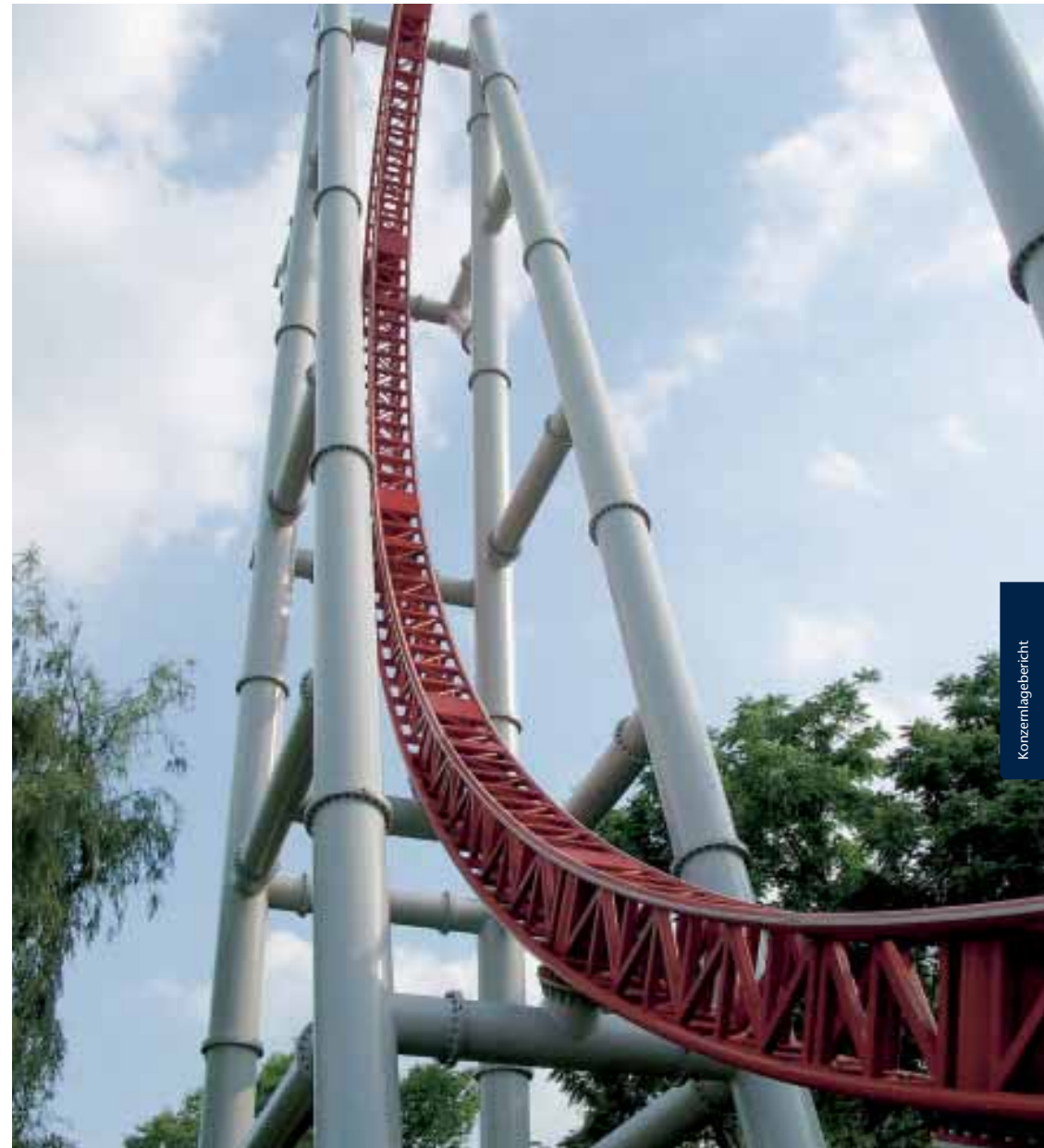
Senkrecht mit Stahl: Achsen, Bremsen und Schienen stecken bei Sturzfahrten extreme Belastungen weg.
