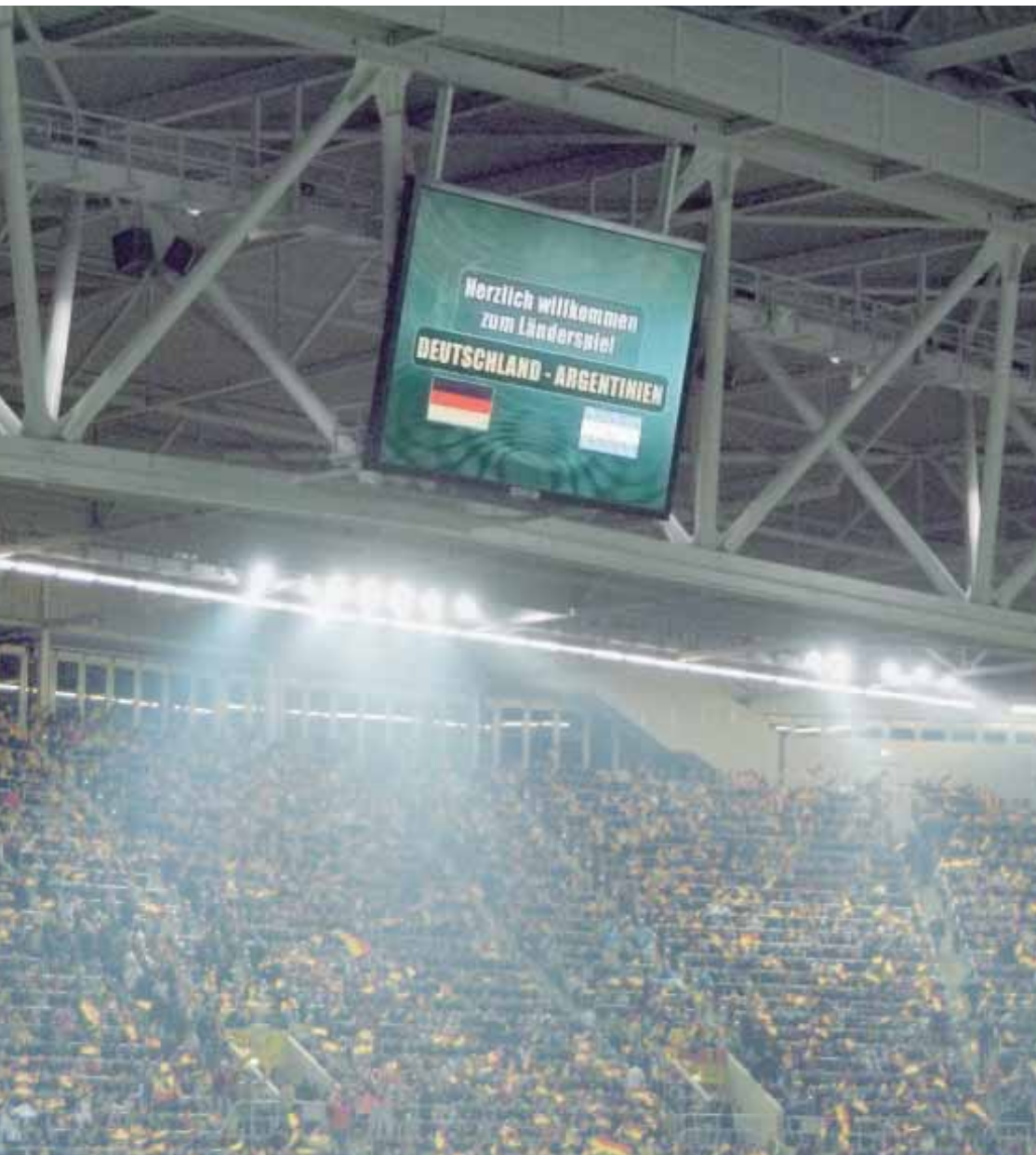
Stahl trägt die Stimmung: Wenn auf den voll besetzten Tribünen die Stimmung überkocht, stützen Stahlträger das Stadion.
