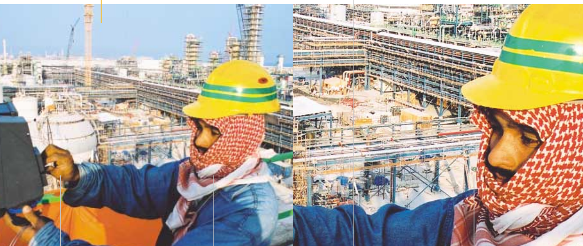
Großbaustelle für Chemiekomplex in Katar
